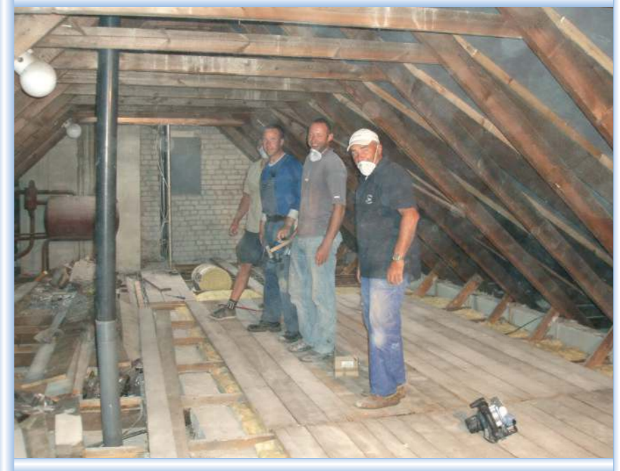
Dachsanierung im YCBG
